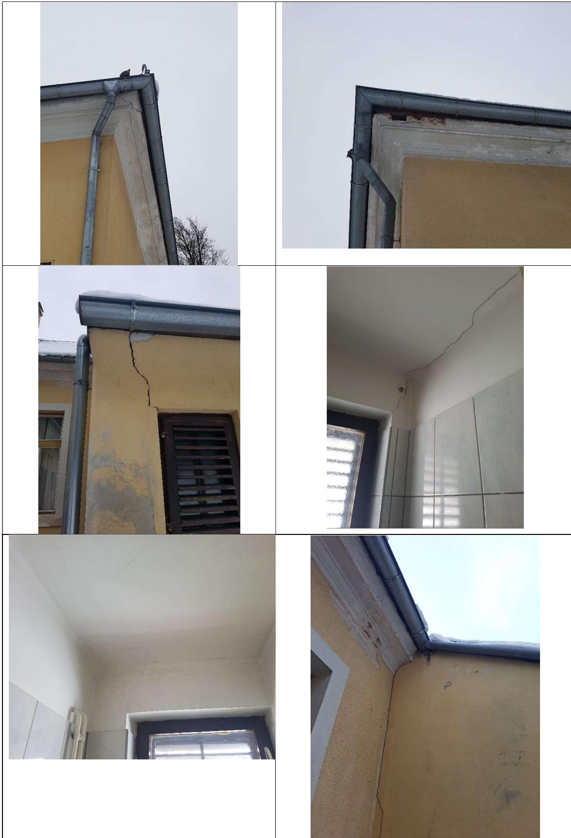
Nakon izvršenog vizualnog pregleda zaključuje se da je građevina u potresu pretrpjela značajnija strukturalna oštećenja u dijelu gdje se nalaze sanitarni čvorovi. Naslućuje se da se dogodilo slijeganje temelja koje je uzrokovalo strukturalne pukotine u nosivim elementima objekta.
